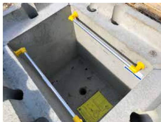
Chambre Telecom L1T avec supports d'équerres Caswick
