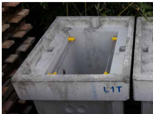
Chambre Telecom L1 avec supports d'équerres Caswick. Le parallélisme est parfait
